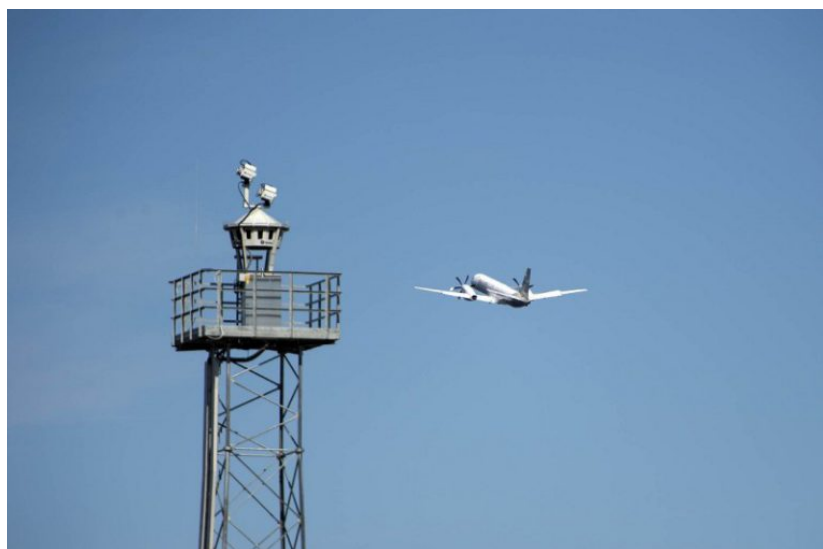
Videocámaras para el control de tráfico remoto en el aeropuerto de Örnköldsvik.
